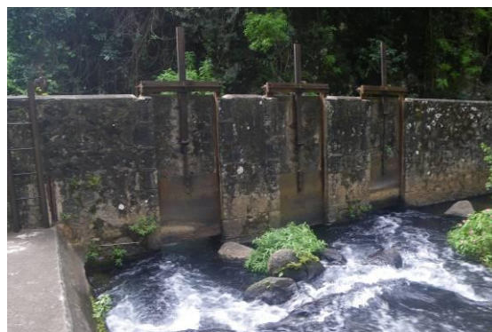
Détail des vannes de la prise d'eau
